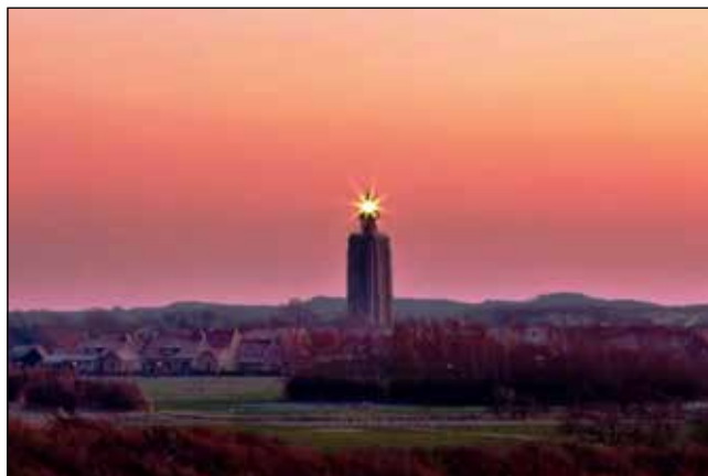
Licht in de duisternis voor zeelui en landrotten
